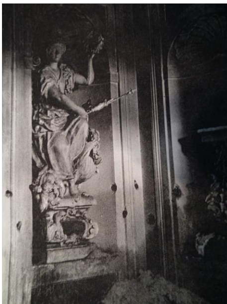
Rys. 17. Fragment wnętrza pałacu Łazienkowskiego z wykonanymi otworami na ładunki wybuchowe (foto Leonard Sempoliński z książki Warszawa 1945).
