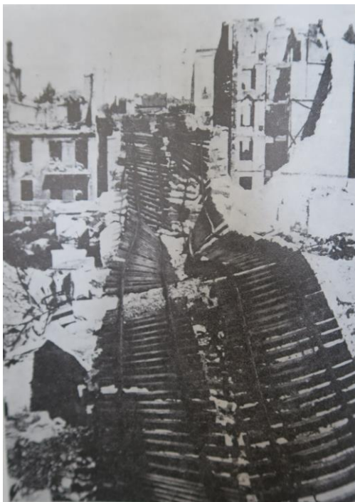
Rys. 18. Zniszczony wiadukt kolejowej linii średnicowej (foto z książki Marka Pisarskiego, Koleje Polskie 1842-1972 WKiŁ 1974).
